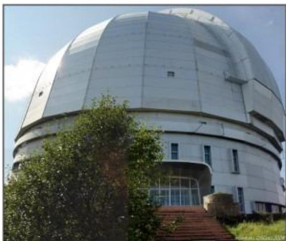
Башня имеет диаметр 44м, высоту 53м, масса купола 1000т, масса телескопа 850т, трубы телескопа 280т, высота 42м. Внутри телескопа на высоте 15-этажного дома укреплена кабина
